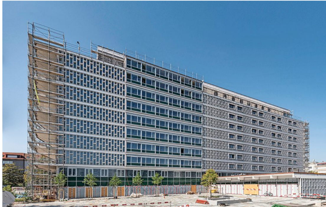
Das alte Felix-Platter-Spital, in dem insgesamt 130 Wohnungen entstehen. Foto: wohnen&amp;mehr / Kathrin Schullhess
