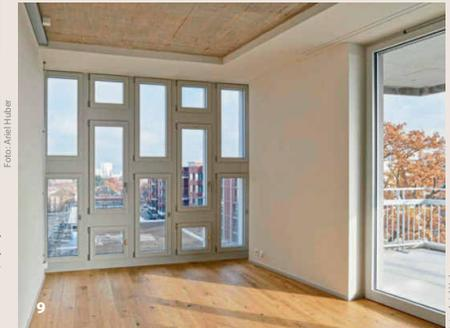
› stellen neue Holzfenster hinter der Fassadenstruktur aus Betonfertigteilen den Wärmeschutz sicher. Eine Flankendämmung im Bereich der Deckenkanten reduziert die baulichen Wärmebrücken auf ein Minimum.
